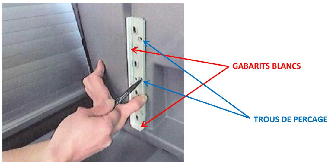
A l'aide d'une mèche de 2,5 de Ø percez maintenant 6 trous à travers le revêtement de la banquette/couchette, avec précaution, et vissez les deux fixations. Serrez en douceur à la main !
